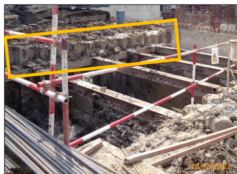
ภาพที่ 2.2-21 แนว Sheet Pile
